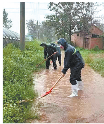
清理道路淤泥 张艳/摄
